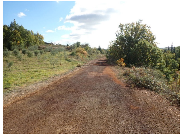
Illustration 33 : Chemin de la mine permettant d'accéder à la verse de l'Atelier
