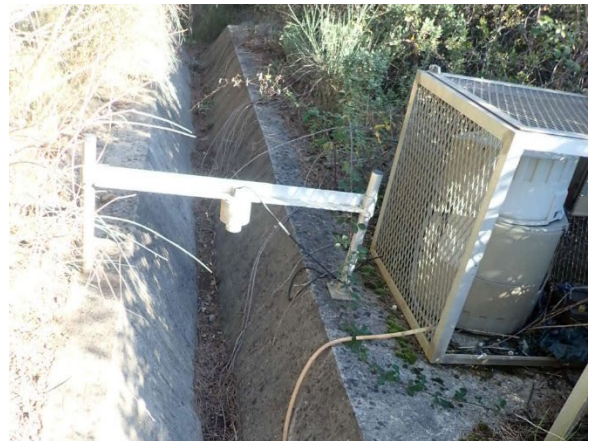
Illustration 49 : Ancien préleveur automatique situé au droit du fossé des eaux superficielles du site
