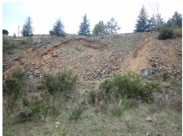
Illustration 27 : Zone de glissement stabilisée sur une banquette au Sud de la verse
