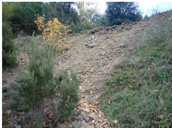
Illustration 26 : Zone de glissement stabilisée sur une banquette au Sud-Ouest de la verse
