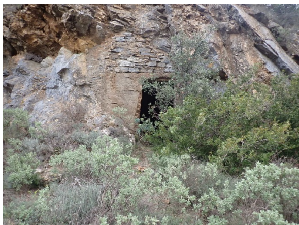
Illustration 20 : Ancienne entrée de galerie, stable
